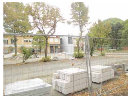
Cantiere alla Polivalente Pietri
